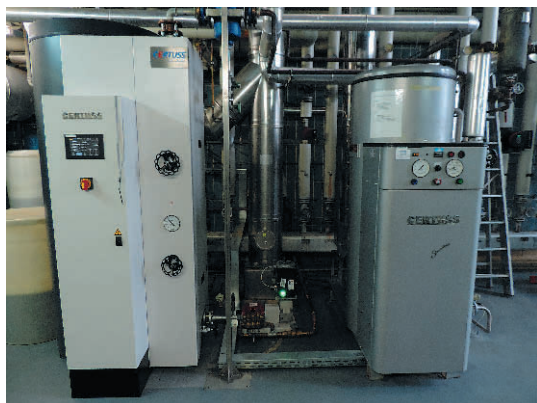
Слева: CERTUSS Universal 850 TC, паропроизводительность 850 кг/ч, теплопроизводительность 557 кВт, работает на жидком топливе. Справа: CERTUSS Junior 600 S, паропроизводительность 600 кг/ч, теплопроизводительность 393 кВт, работает на жидком топливе.
