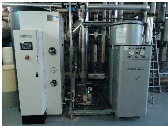
Esquerda: CERTUSS Universal 850 TC, capacidade de vapor de 850 kg/h, rendimento térmico de 557 kW, óleo aquecido. Lado direito: CERTUSS Junior 600 S, capacidade de vapor de 600 kg/h, rendimento térmico de 393 kW, óleo aquecido.
