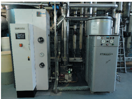
Gauche: CERTUSS Universal 850 TC, débit de vapeur 850 kg/h, puissance calorifique 557 kW, fioul. Droite: CERTUSS Junior 600 S, débit de vapeur 600 kg/h, puissance calorifique 393 kW, fioul.
