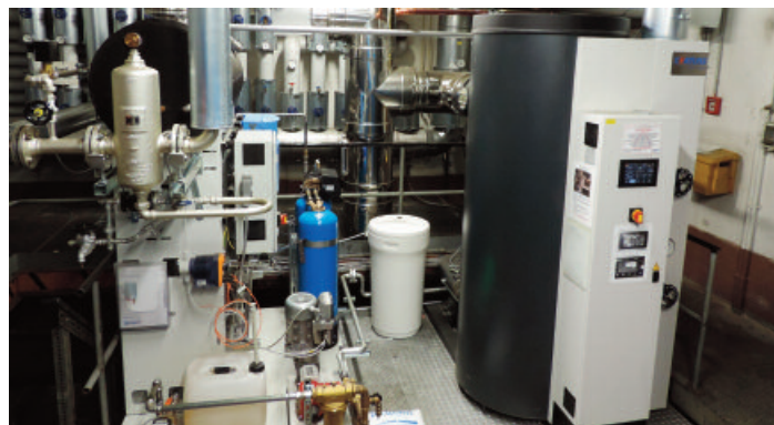
Universal 850 TC gás com unidade de abastecimento CVE
