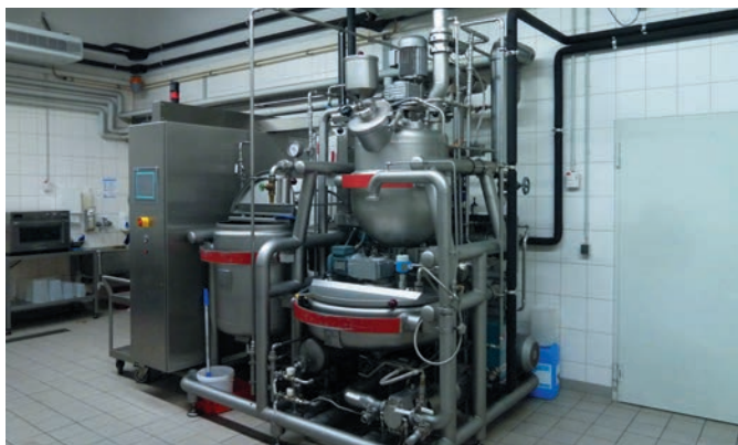
Instalação de cozinha para recheios de bombons de chocolate
