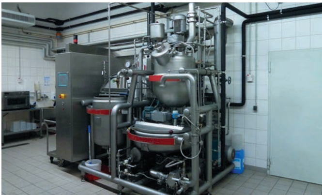
Kochanlage für Pralinenfüllungen
