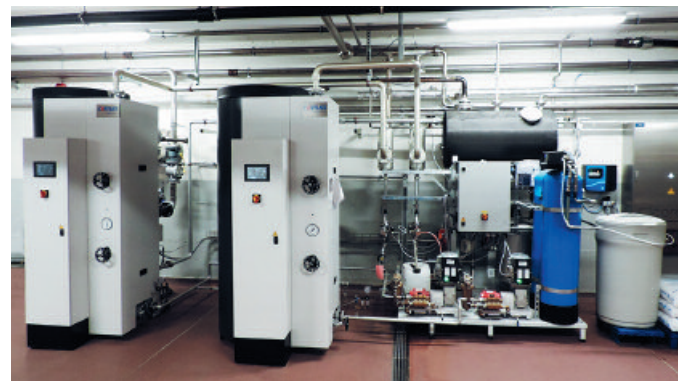
CERTUSS installation double 2 x Universal 850 TC avec un CVE
